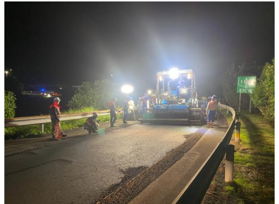
＜舗装工事 作業状況②＞
