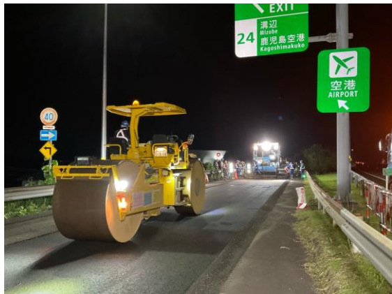
＜舗装工事 作業状況①＞
