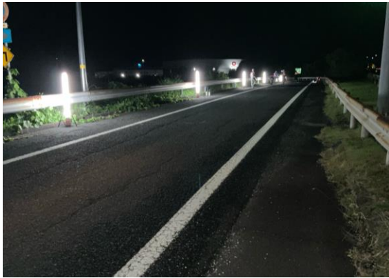
＜舗装工事 補修前＞
