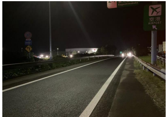
＜舗装工事 補修後＞
