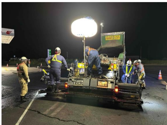
＜舗装施工状況＞
