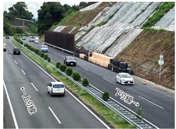
下り線(206.9 付近) 路肩固定規制状況
