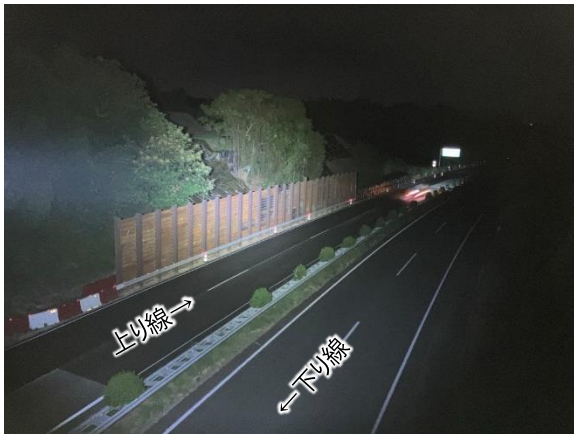
上り線(206.3 付近) 路肩固定規制状況
