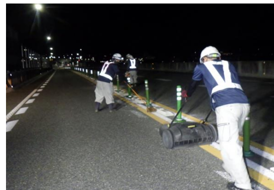
《清掃作業状況》
