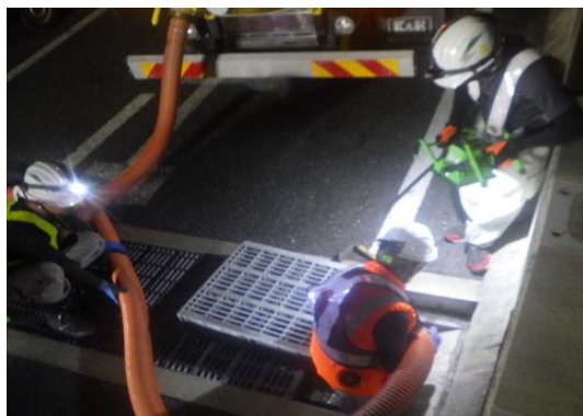
《清掃作業状況》
