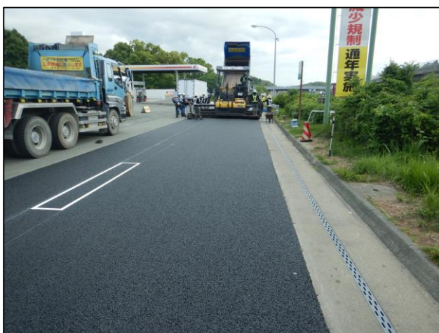
《舗装施工状況》
