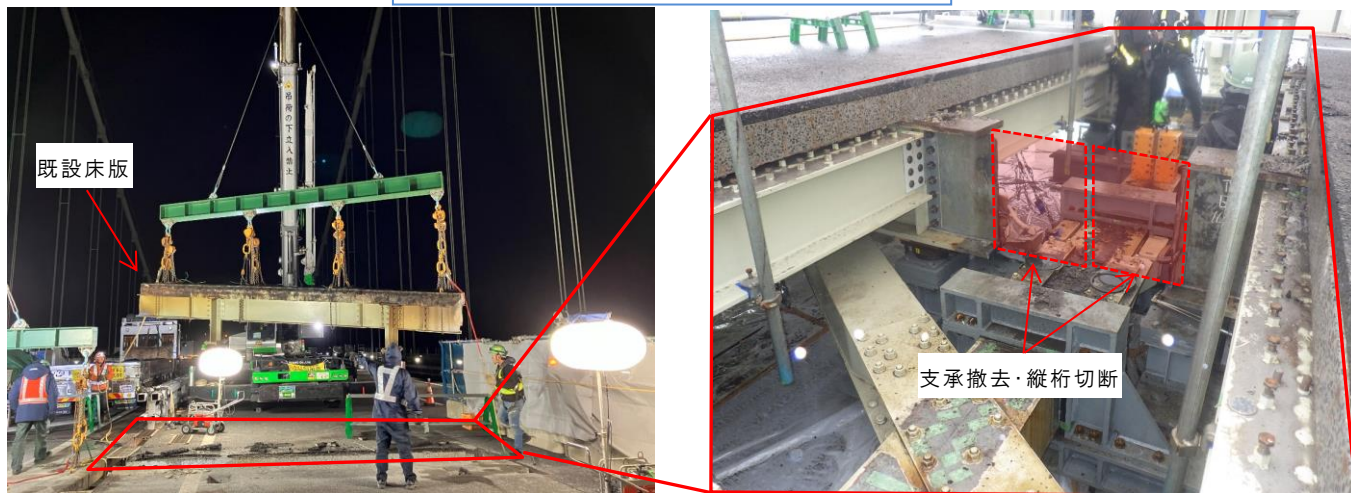
既設床版・横桁・支承の撤去・縦桁の切断
