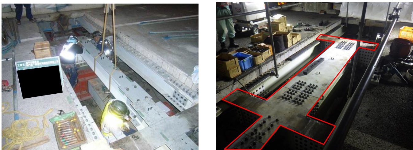
新設支承・横桁・縦桁の設置
