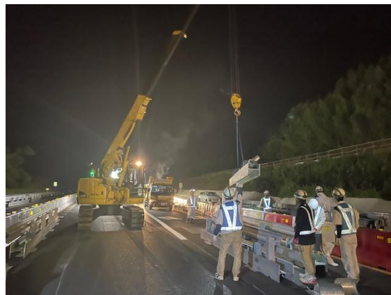
＜仮設防護柵工＞
