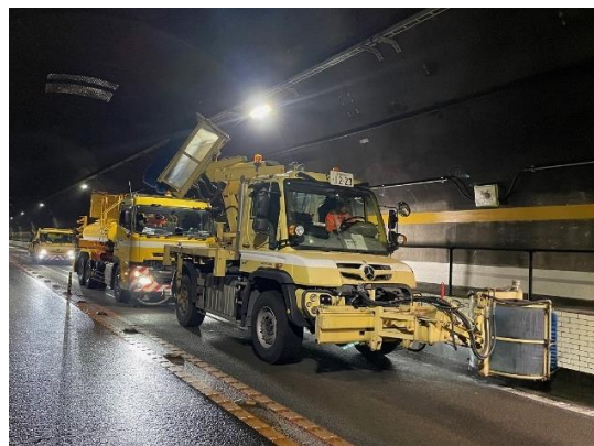
<トンネル側壁清掃>
