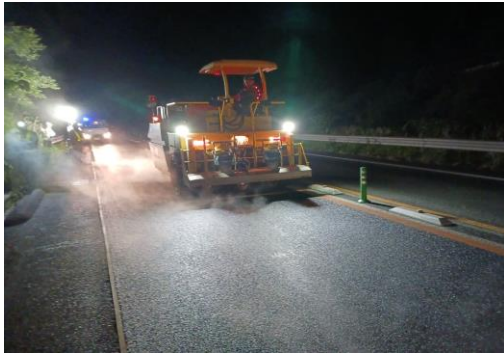
〈舗装補修工事〉
