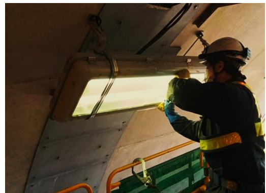
〈トンネル照明点検〉
