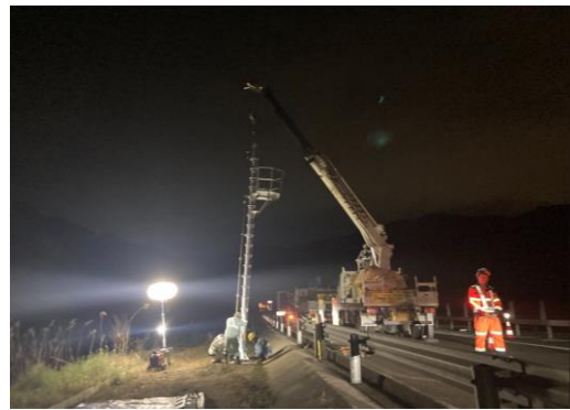
〈通信設備工事〉
