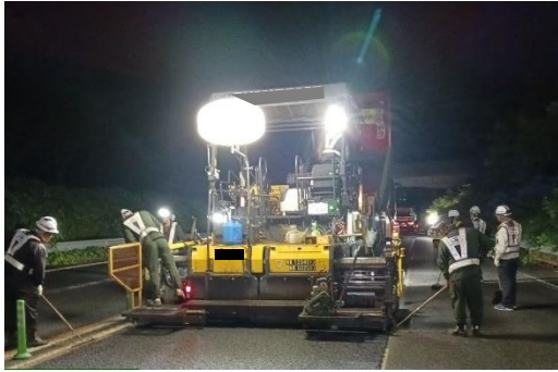
＜舗装補修工事＞
