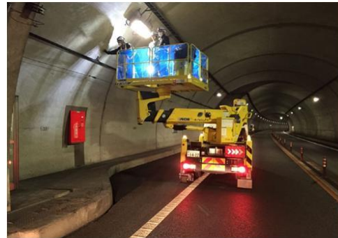
＜トンネル照明点検＞
