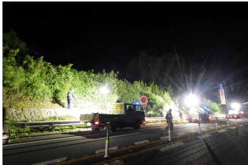
＜樹木伐採作業＞
