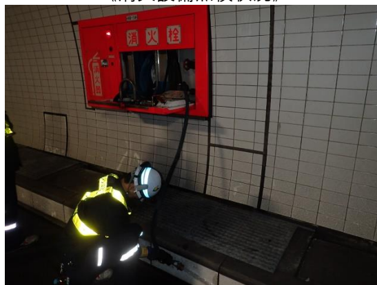
《消火設備点検状況》
