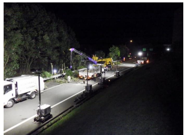
＜樹木伐採作業＞
