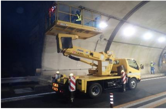
＜トンネル照明点検作業＞
