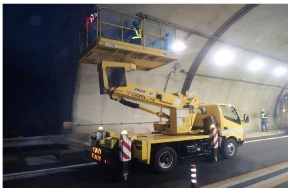
＜トンネル照明点検作業＞
