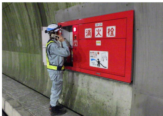
＜トンネル非常用設備点検＞
