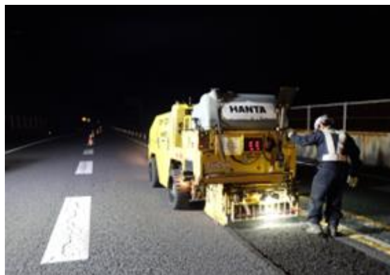
＜舗装補修工事＞
