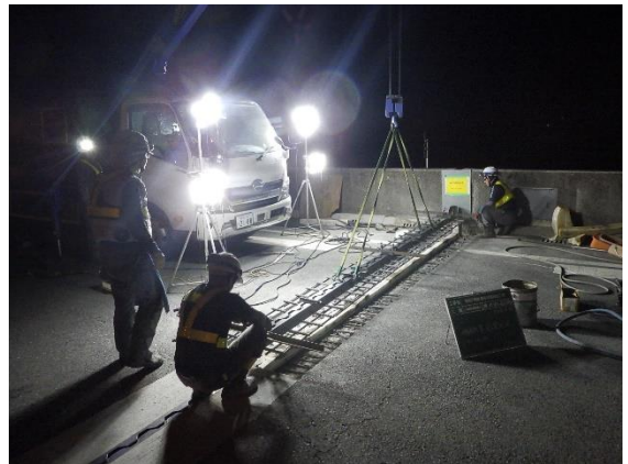
< 伸縮装置取替工 >
