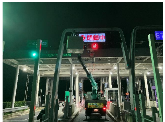
< ETC 設備工事 >
