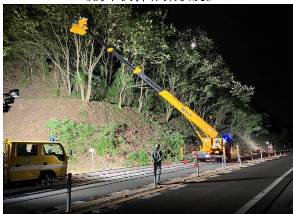
《樹木伐採作業状況》
