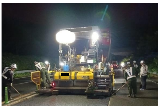
<舗装補修工事>
