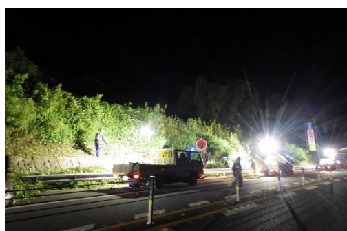
<樹木伐採作業>
