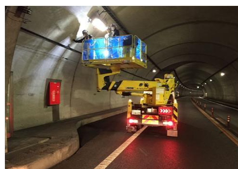
<トンネル照明点検>
