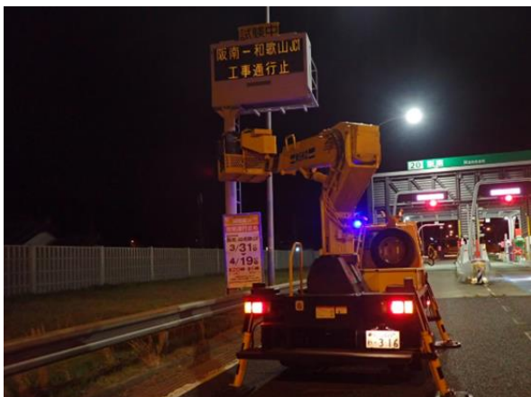
《構造物点検状況》
