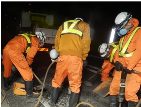
《構造物補修状況》
