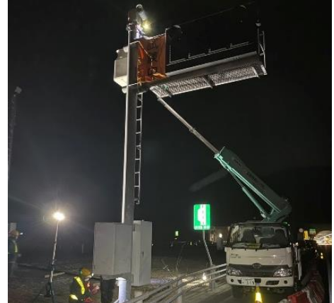
<路側設備撤去>
