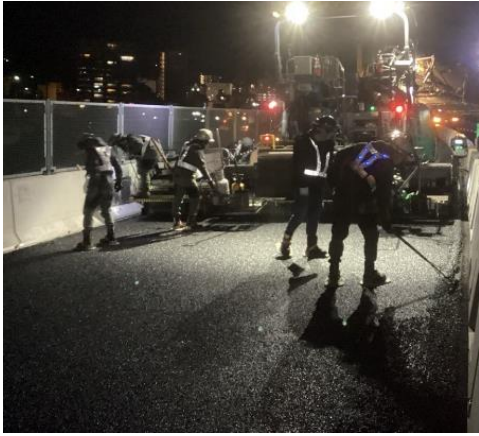
<舗装・路面標示工>
