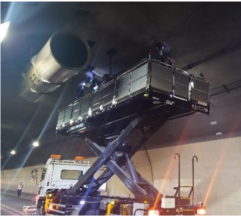
<トンネル換気設備撤去>
