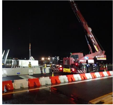
<仮設防護柵撤去>
