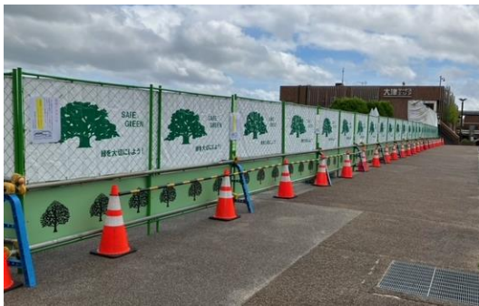
上り線 展望スペースの一部閉鎖
