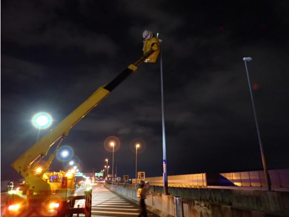
《点検状況写真》
