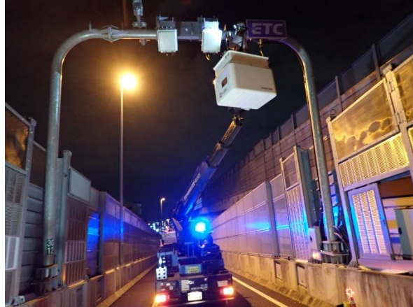
《点検状況写真》
