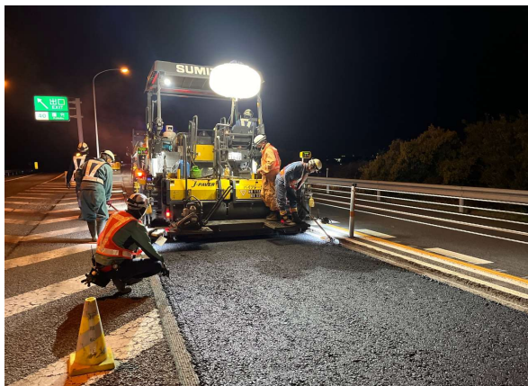
<舗装補修工事>
