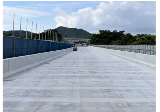
床版取替 施工後(床版防水工施工前)
