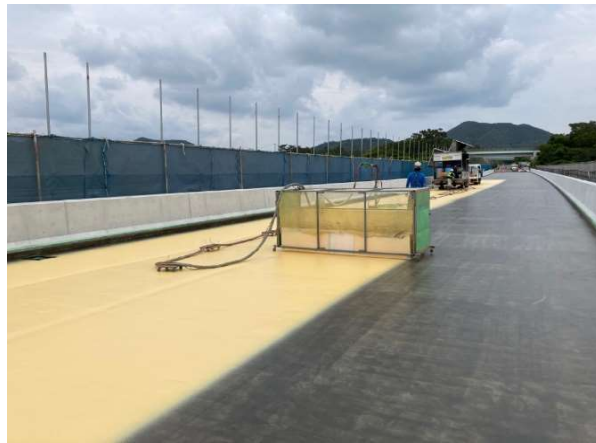
床版防水工の作業状況
