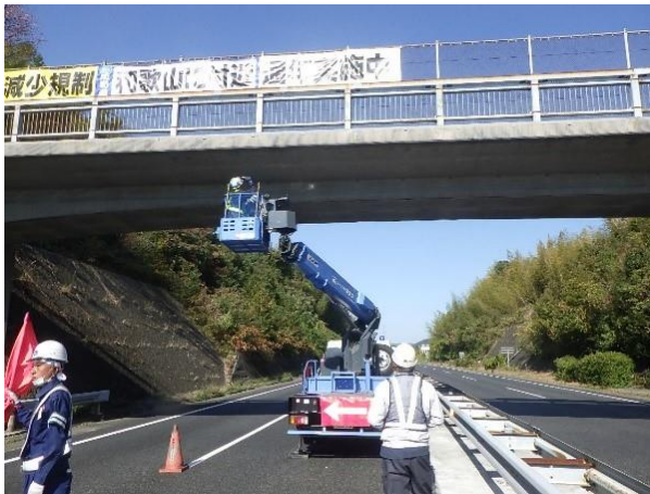
《跨道橋点検状況(作業イメージ)》
