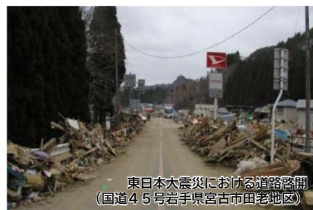
[道路啓開後の状況]
