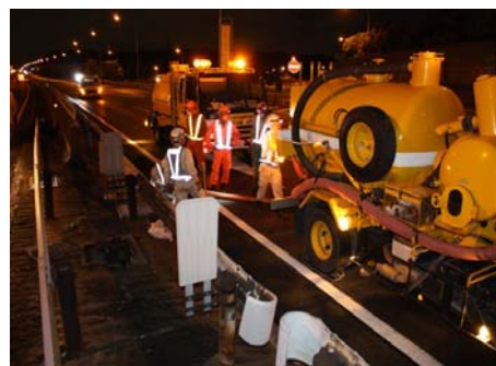
【排水設備清掃】
