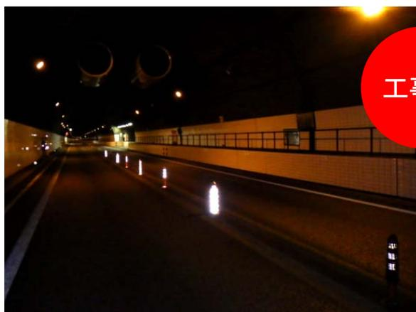
破損・老朽化した車線分離標の取替を実施。
