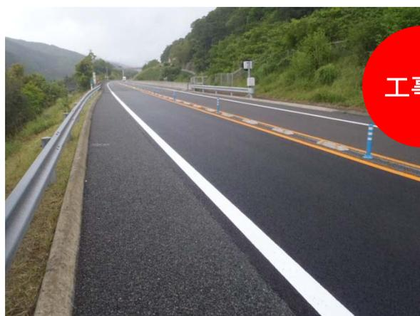
老朽化した舗装路面の凹凸や、ひび割れ箇所を補修。
