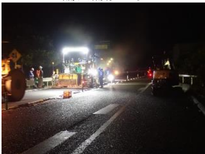
《舗装補修工事》
