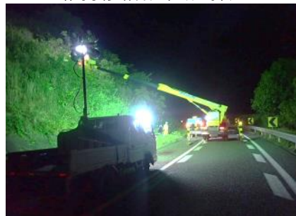
《維持修繕作業(伐採)》
