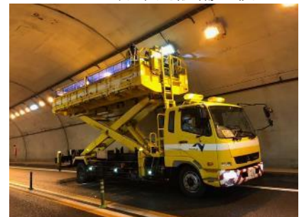
《トンネル非常用設備点検》
