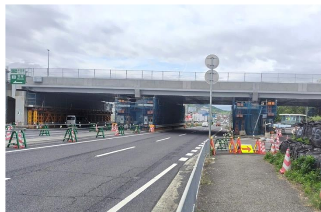
橋梁取替後状況
