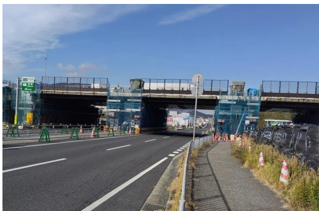
橋梁取替前状況
