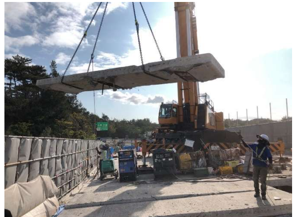
損傷した床版の撤去作業状況
