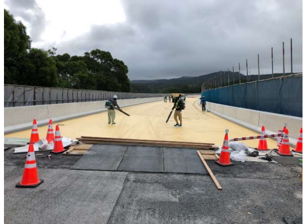
床版防水工の作業状況
