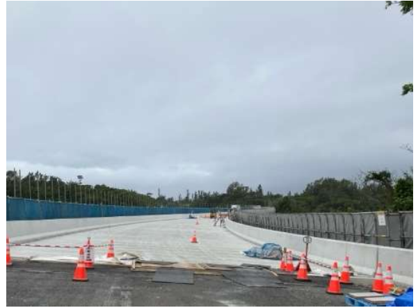
床版取替 施工後(床版防水工施工前)
