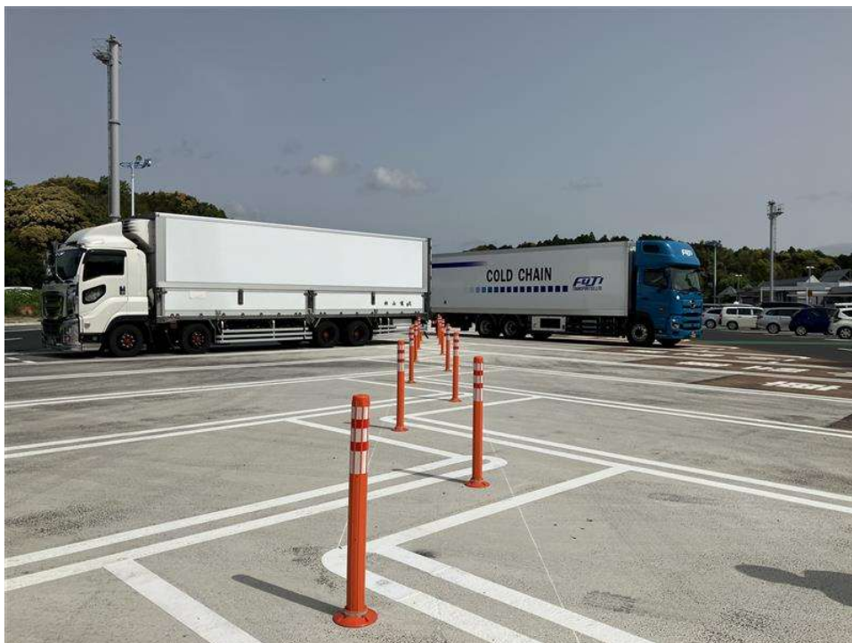
基山PA(下り線) V字駐車マス
