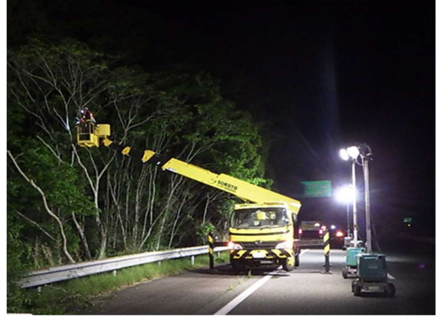
＜樹木伐採作業＞
