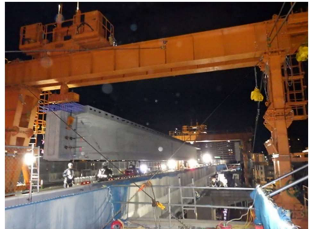
＜橋梁桁架設＞
