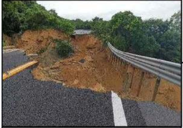
・土石流による道路崩壊 崩落は、約25,000m 3 (幅80m×長さ400m)
