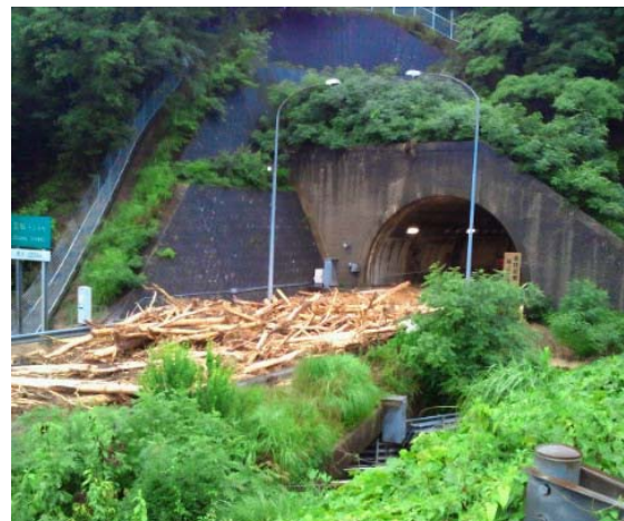
志和トンネル西坑口
