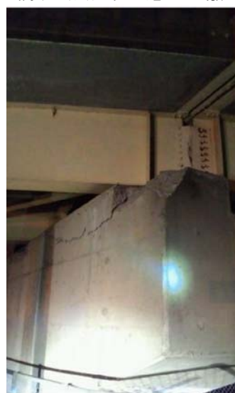
橋梁下部工の角かけ(下り線)177.8KP 秋津川橋(益城熊本空港IC～嘉島 JCT 間)
