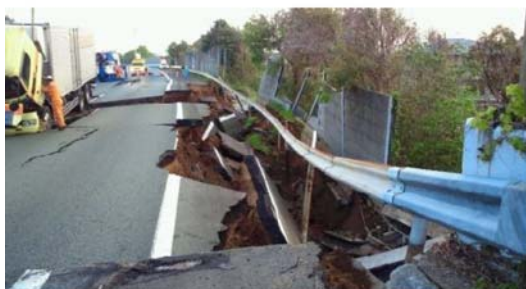
土工部盛土法面崩壊(下り線)177.8KP (益城熊本空港IC～嘉島 JCT 間)
