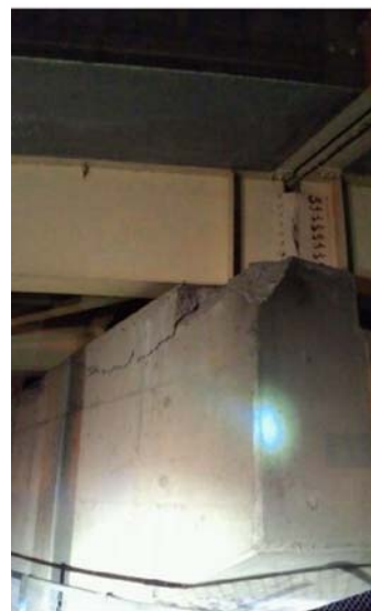
橋梁下部工の角かけ(下り線)177.8KP 秋津川橋
